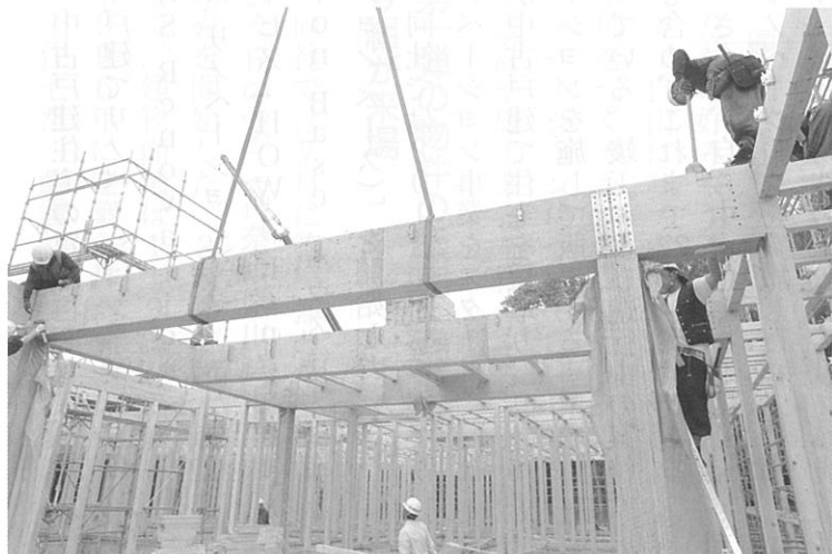
今回の性能検証により、プレセッターSUについても、中大規模木造で安心して使用できる性能を備えていることが確認できた。この結果を受けて、今後は中大規模木造におけるプレセッターSUの使用比率を高めていきたい考え
