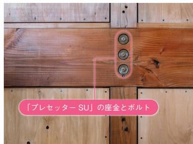
「睦モクヨンビル」の中央に位置する2間角の大きな吹抜け（1・2階部分）。現しとなった梁が交差しているが、梁受け金物「プレセッターSU」の本体は内部に隠れているため、ノイズのない美しい納まりとなっている（写真右）。梁と梁の接合部。スリットの内部に埋め込まれたコンパクトな「プレセッターSU」が確認できる。仕口の断面欠損が少なく、あらゆる方向からの力に対して強靱に抵抗する（写真左上）。上下の管柱と床梁の取合い。「プレセッターSU」の座金とボルトが露出するのみで、むしろ、デザインのアクセントにもなっている（写真左下）
