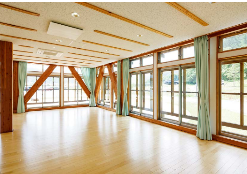
交流・議会ゾーン1階の町民ホール。設備配管の梁貫通は補強方法が確立されておらず、またいたずらに梁せいを上げると階高に影響するため、天井を設けました。
