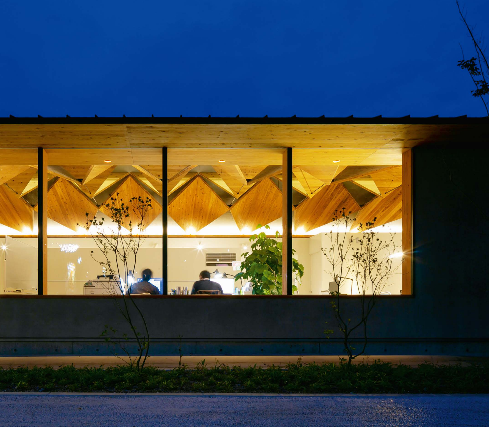
事務所棟夜景。厚さ54mmのCLTパネルで構成する3次元(3D)トラスが、屋外からは照明器具のようにも見えます。
