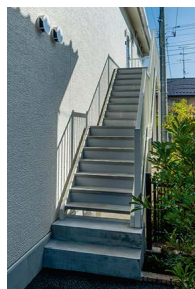
屋外鉄骨階段廊下 「段十廊Ⅱ」
