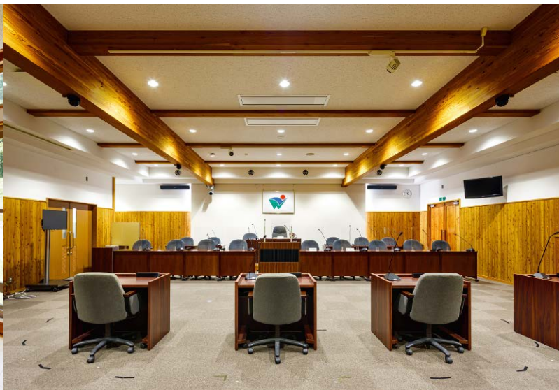
交流・議会ゾーン2階の議場。梁には燃えしろ設計を適用し、現し仕上げとしています。接合部には防火被覆として埋木を措置しています。
