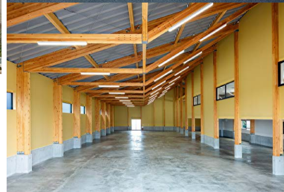
左上は外観。軒下部分、出入り口周囲の外壁には地元産のスギを用いています。右上は2階事務所。壁と天井に断熱材を充てんし快適性を高めています。右下は倉庫。左手に並ぶ柱を耐力壁として機能させています。
