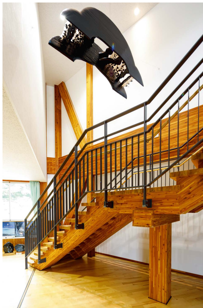
1階ホールの階段。右奥は行政ゾーン、左手は交流・議会ゾーンです。2つの異なる構造体は階段の向こうで切り離され、エキスパンションジョイントで結ばれています。
