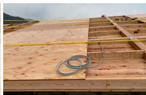
倉庫棟の施工写真。張弦トラスの端部は、臥梁の上に突き出る壁柱の一部に定着させています(写真左)。トラスを架け終えると、ストレススキンパネルを落とし込みました(写真中)。パネル内の垂木だけで応力を負担していないため、照明器具用の配線を貫通させることが可能(写真右)。パネルは構造用合板で覆い、トラスの上弦材に留め付けました。
