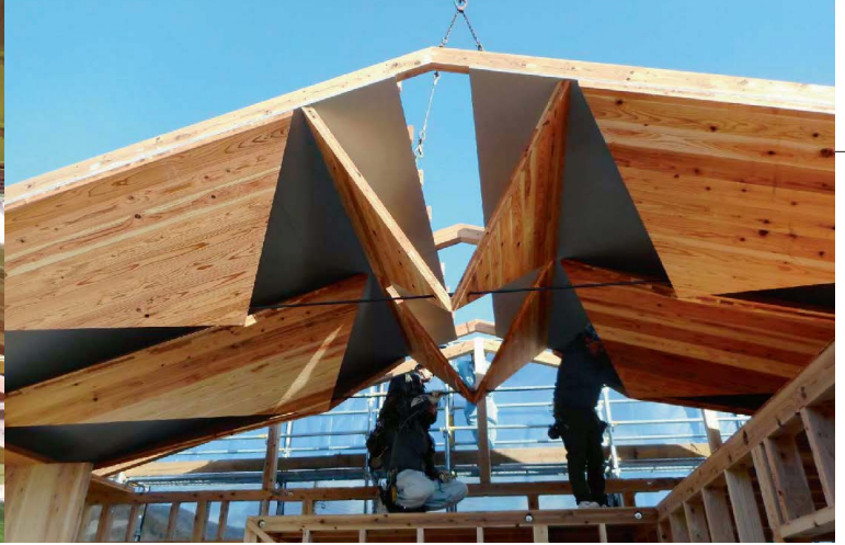
事務所棟小屋組みを組み上げるための治具と現場での架設の様子。現場ではこの治具一つで、全ての小屋組みを3日間で組み上げました。
