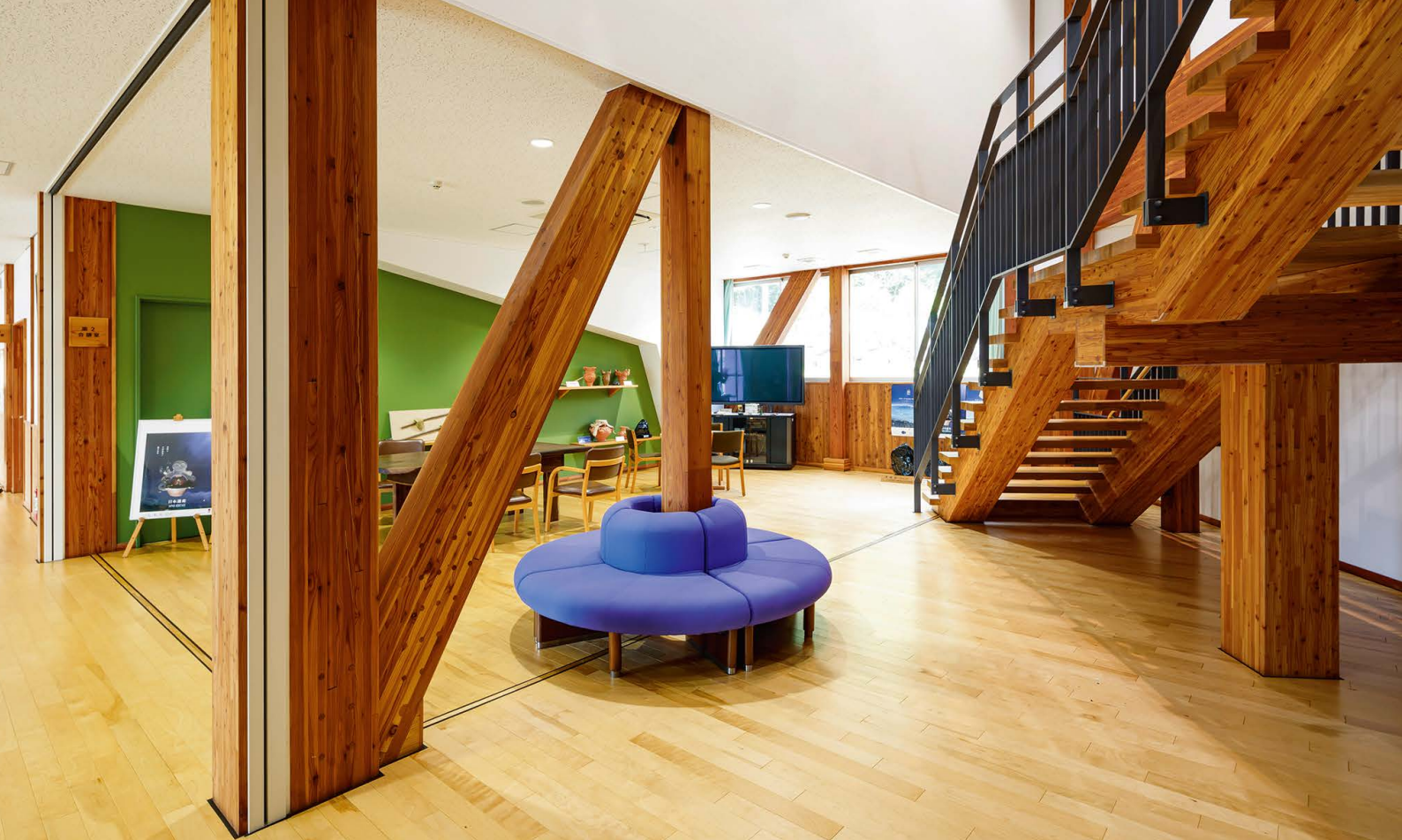
交流・議会ゾーン1階のホール。左手に見える筋交いや右手階段脇の壁面に現れる大梁が、構造体の力強さを感じさせます。
