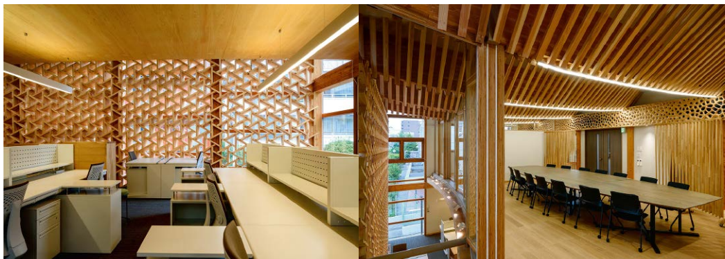
左は2階編集室。右は3階会議室。3階の屋根梁は方杖(ほうづえ)で覆われ、全体は船底のようです。方杖の加工や取り付けにはAR(拡張現実)を応用したガイダンス技術を取り入れています。
