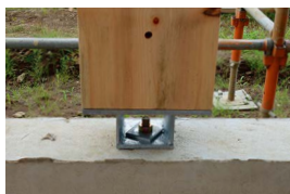
製作金物(柱脚金物)
