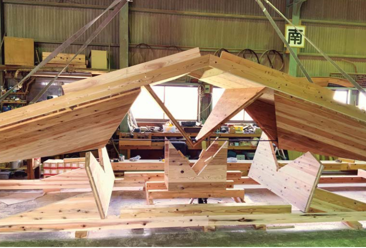
事務所棟小屋組みを組み上げるための治具と現場での架設の様子。現場ではこの治具一つで、全ての小屋組みを3日間で組み上げました。
