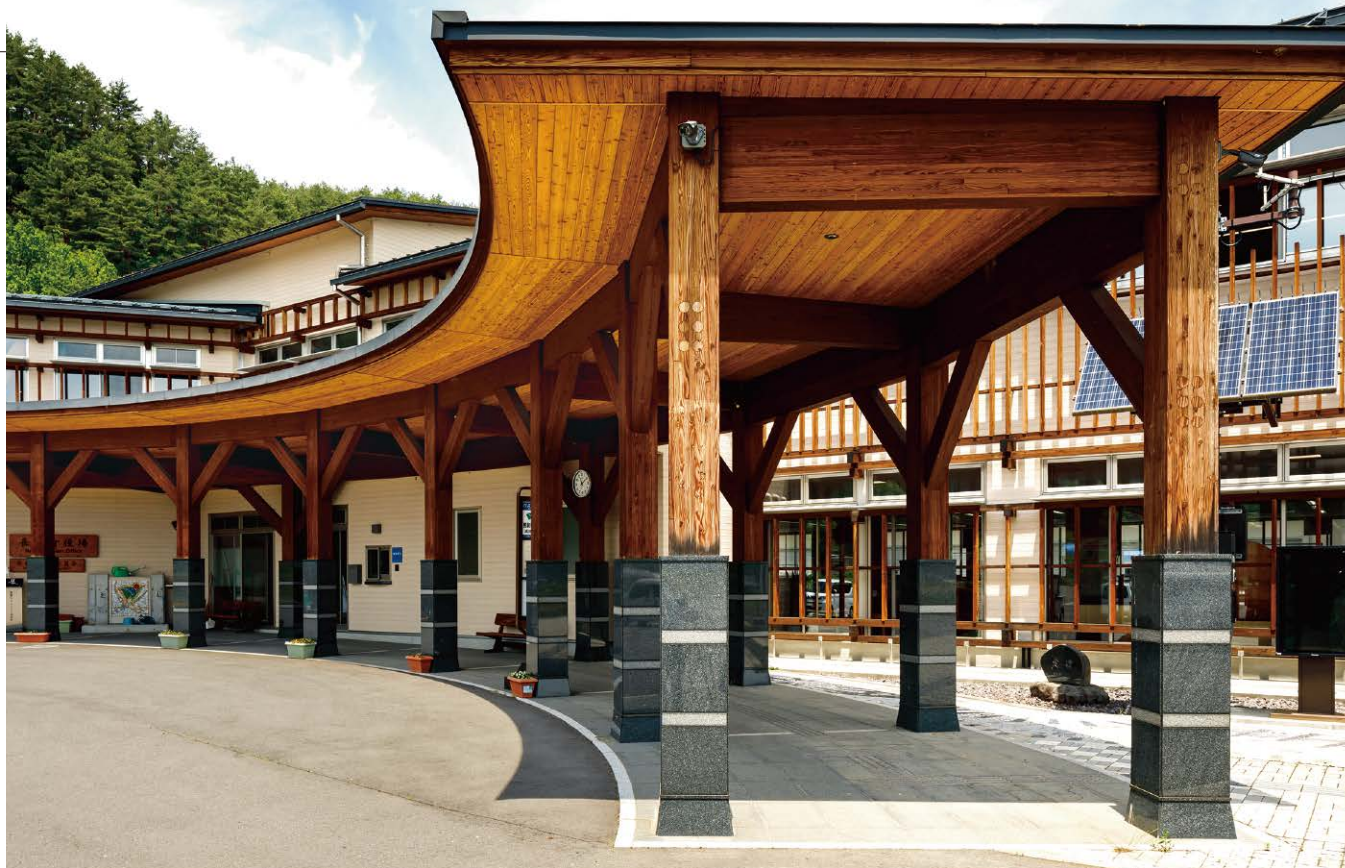
キャノピーは庇を長めに張り出させ、柱の下部3分の1は石張りすることで、現し仕上げの木部の耐久性の確保に努めています。
