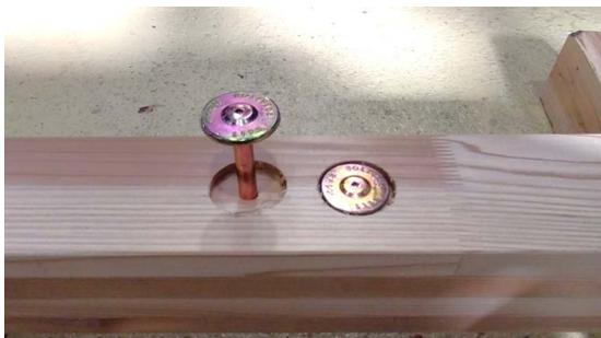
1. 柱・梁の所定の穴に M12 中ボルトと丸座金又は PS 座付ボルトを挿入します。
