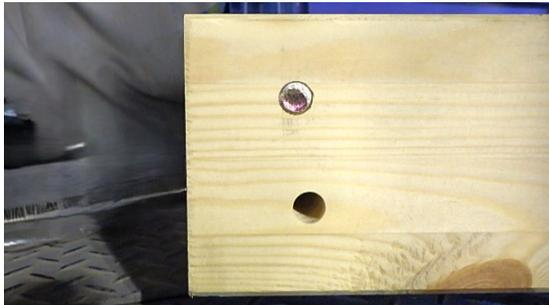
1. 接合する横架材に先行ピンが打ち込まれていることを確認します。
