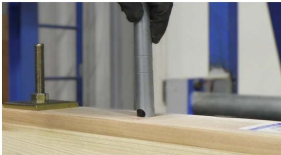
1. 土台の所定の位置にパイプ金物を挿入します。
