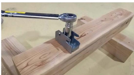
5. ナットをレンチで適度 (推奨トルク 20N・m) に締め付けて施工完了です。
