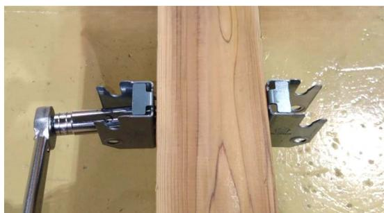
4. ナットをレンチで適度 (推奨トルク 20N・m) に締め付けて施工完了です。
