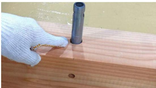
2. 刻印線を参考に指定の高さまでパイプ金物を入れ、梁・桁と金物の穴が合っていることを確認します。
