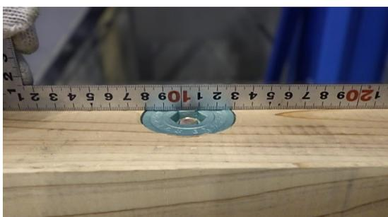
4. 金物上面が土台天端以下の位置に来るまで締めて施工完了です。
