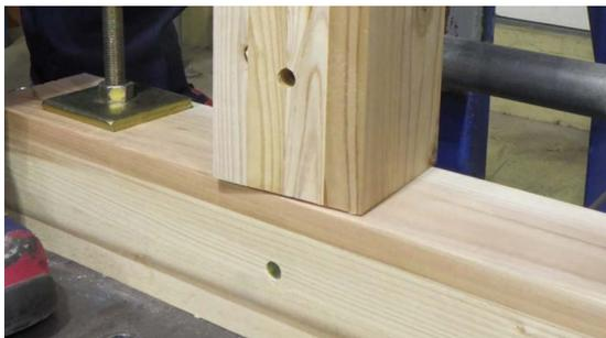
3. 柱が横架材に接するまで回転させたり、柱頭側の木口をゴムハンマー等で叩いて落とし込みます。
