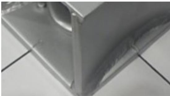
2. 金物をアンカーボルトに通して、後で設置する柱のスリットの向き及び基礎の墨出しと金物の刻印線を合わせて設置します。
