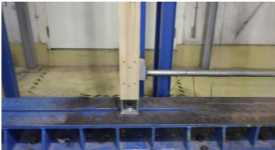
3. 柱の穴位置にドリフトピンを打ち込んで施工完了です。
