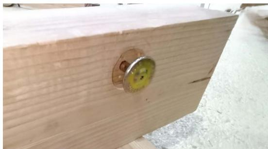
1. 柱・梁の所定の位置に M12 中ボルトと丸座金又は PS 座付ボルトを挿入します。
