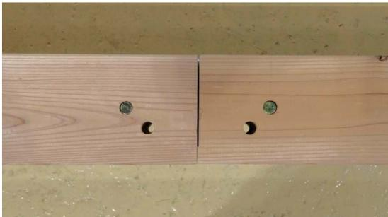
3. 土台の後打ちピン穴と金物の穴が合っていることを確認します。
