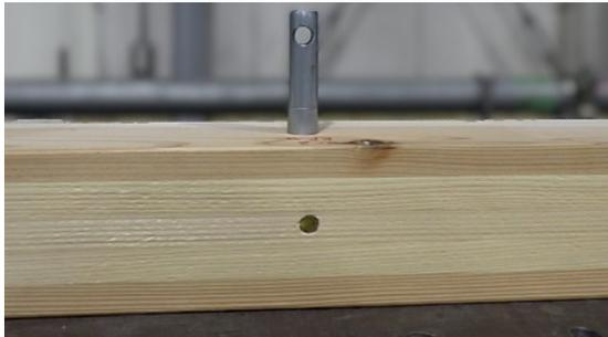
1. 横架材に接合されている金物がドリフトピン等で固定されていることを確認します。
