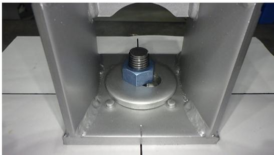
3. アンカーボルトに専用の偏芯座金を通し、ナットで留め付けて施工完了です。
