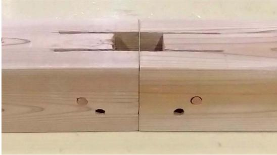
1. 接合する土台の上側の穴に先行ピンが入っていることを確認する。
