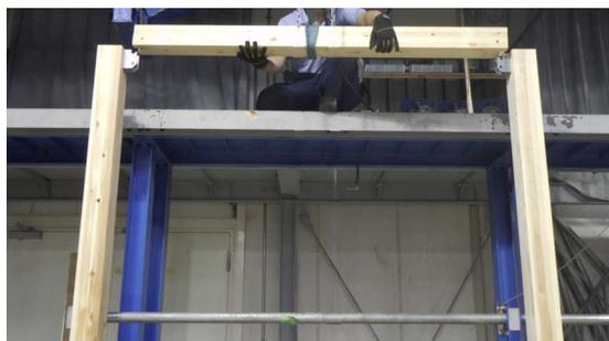
2. 横架材を水平にして、金物が取り付けいた箇所へ横架材を落とし込みます。
