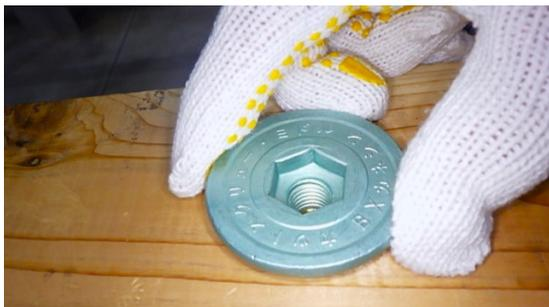
2. 金物をボルト穴に入れ、手回しでボルトと接合します。
