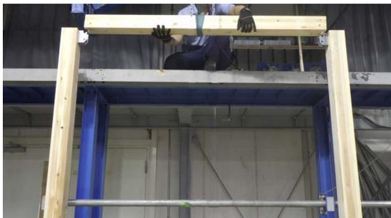
2. 横架材を水平にして、金物が取り付けられた箇所へ横架材を落とし込みます。
