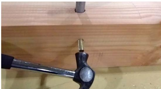
3. 梁・桁の穴位置にドリフトピンを打ち込んで施工完了です。
