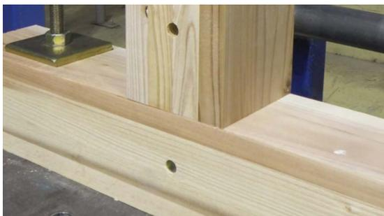
4. 柱を回して金物と柱のドリフトピン穴位置を合わせます。
