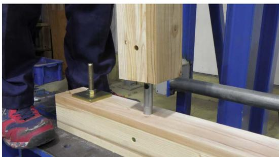
2. パイプ金物に柱底部の穴を通します。
