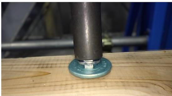
3. 専用ビットまたは簡易ビットを取り付けたインパクトレンチで金物を締め込みます。
