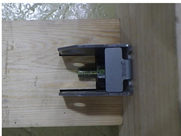
長いボルトを取り付けて、梁を施工すると梁が落ちません。
