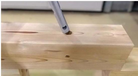
1. 梁・桁の所定の位置にパイプ金物を挿入します。
