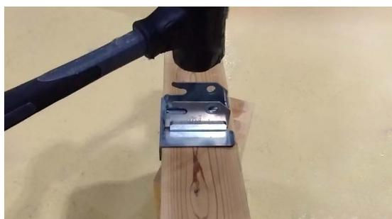
2. 金物をまっすぐになるように置き、ゴムハンマーなどで叩き、金物背面のツメを木材に入れて、回転しないように固定します。反対側も同様に固定します。
