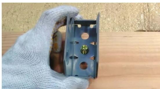
2. 金物の背面の穴にボルトを通し、木材に対して、まっすぐになるように向きを調整します。
