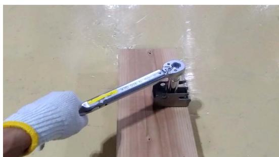
5. ナットをレンチで適度 (推奨トルク 20N・m) に締め付けて施工完了です。
