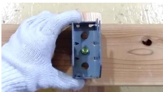
2. 金物の背面の穴にボルトを通し、木材に対して、まっすぐになるように向きを調整します。
