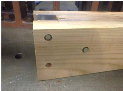
1. 接合する横架材に先行ピンが打ち込まれていること及びスリットにプレート金物が入っていることを確認します。
