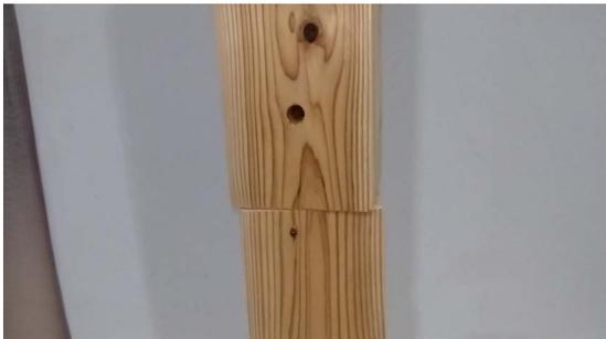
3. 柱同士が接するまで上階側の柱を回転させたり、柱頭側の木口をゴムハンマー等で叩いて落とし込みます。
