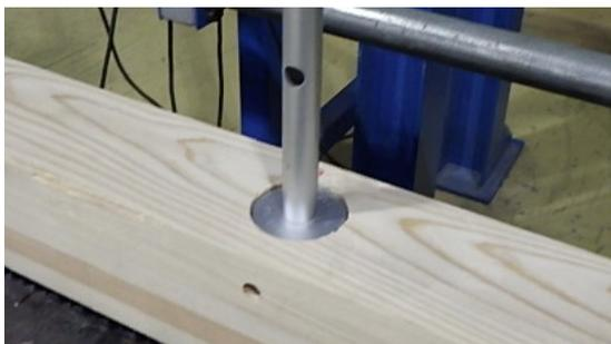
4. 土台の穴を金物に通して、土台を設置します。
