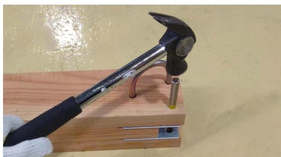
3. 先行ピンの穴 (梁の木口側上端及び内側すべて) にドリフトピンを打ち込んで施工完了です。
