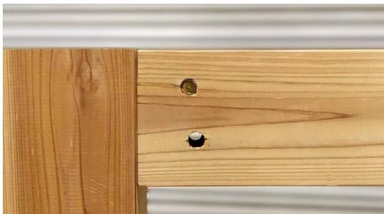
3. 横架材の後打ちピン穴と金物の穴が合っていることを確認します。
