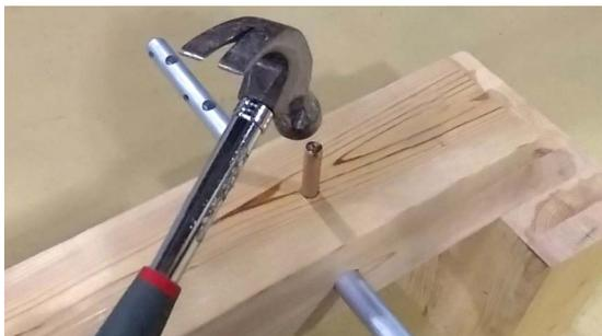
3. 梁・桁の穴位置に脱落防止用のドリフトピンを打ち込んで施工完了です。
