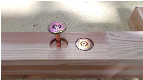
1. 柱・梁の穴位置のすべてに M12 中ボルトと丸座金又は PS 座付ボルトを通します。
