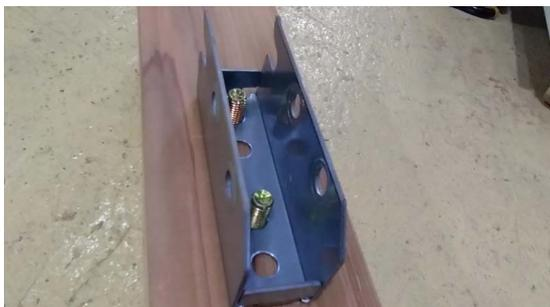
2. 金物の背面の穴にボルトを通します。
