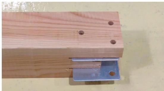
1. 梁のスリットにプレート金物を差し込みます。
