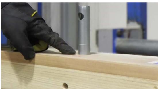
2. 刻印線を参考に指定の高さまでパイプ金物を入れたら、土台と金物の穴が合っていることを確認します。
