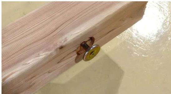
1. 土台の所定の位置に M12 中ボルトと丸座金又は PS 座付きボルトを挿入します。
