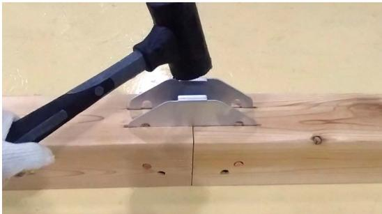
2. 先行ピンが入っている2本の土台の木口を合わせ、上から金物をスリットに通します。金物の上端と土台の天端の高さが同じになるまで、ゴムハンマー等で挿入します。
