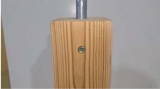
1. 柱頭に接合されたパイプ金物がドリフトピン等で固定されていることを確認します。
