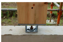
製作金物(柱脚金物)
