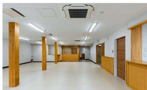
扁平柱には燃えしろ設計を適用しています。現し仕上げの多用で木の温かみを感じられる空間に仕上がっています。
