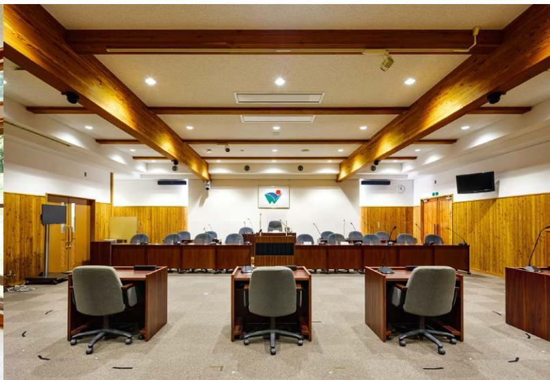
交流・議会ゾーン2階の議場。梁には燃えしる設計を適用し、現し仕上げとしています。接合部には防火被覆として埋木を措置しています。
