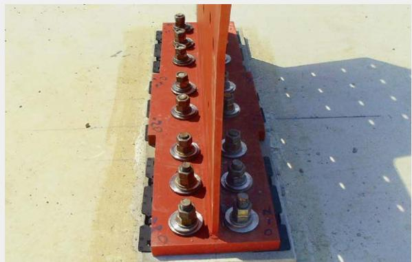
柱脚金物の取り付けには、アンカーボルト (M16) の芯ずれを最大±9mm吸収する「親子フィラー」を用いています。
