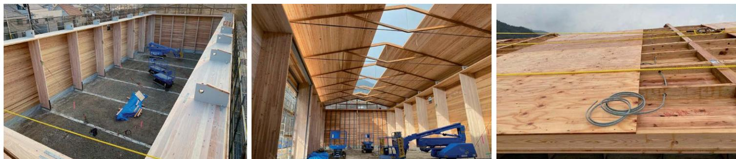
倉庫棟の施工写真。張弦トラスの端部は、臥梁の上に突き出る壁柱の一部に定着させています(写真左)。トラスを架け終わると、ストレススキンパネルを落とし込みました(写真中)。パネル内の垂木だけで応力を負担していないため、照明器具用の配線を貫通させることが可能(写真右)。パネルは構造用合板で覆い、トラスの上弦材に留め付けました。
