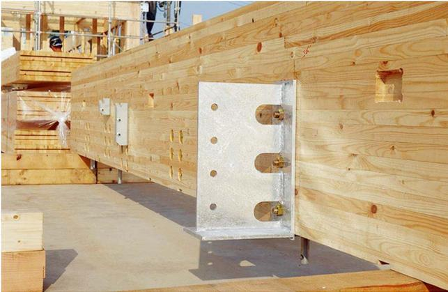
住宅用金物も大断面用梁受け金物であるTS金物も使用できないケースでは、接合部ごとに設計した金物を製作する必要があります。そうしたご要望にお応えするため、図面や資料を基に最適な製作金物をご提案します。建物の計画段階から詳細設計段階まで、幅広い対応が可能です。見積り金額は製作金物のみならず既製品を含め、建物1棟分としてご提示させていただくことが可能です。
