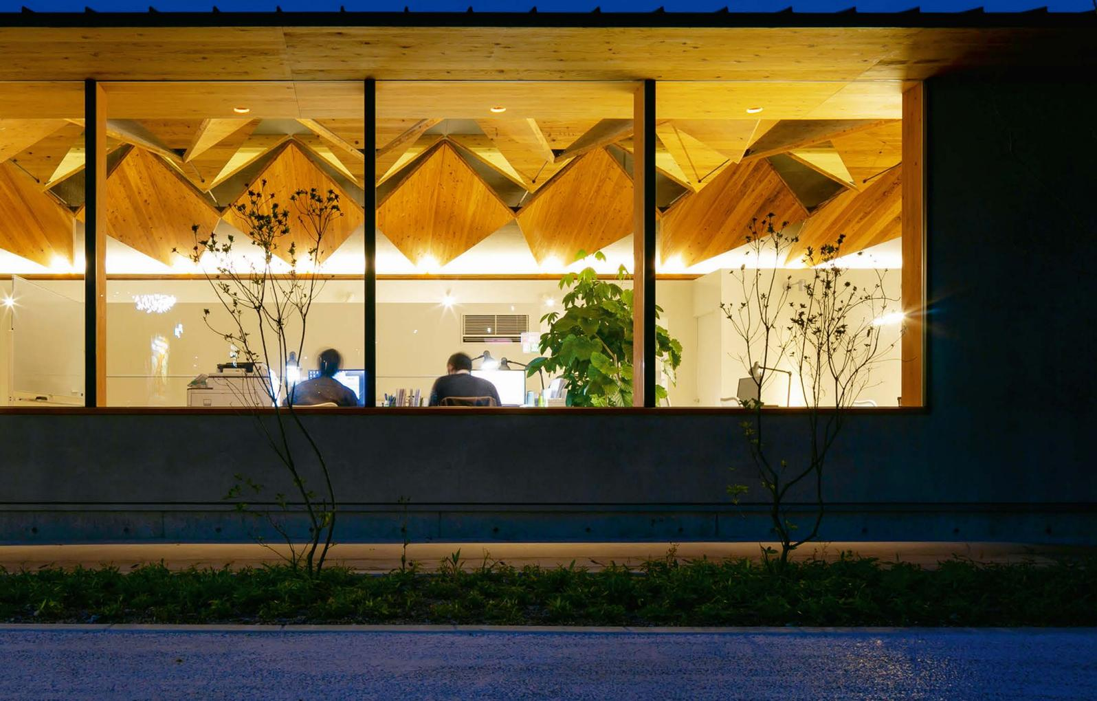
事務所棟夜景。厚さ54mmのCLTパネルで構成する3次元(3D)トラスが、屋外からは照明器具のようにも見えます。
