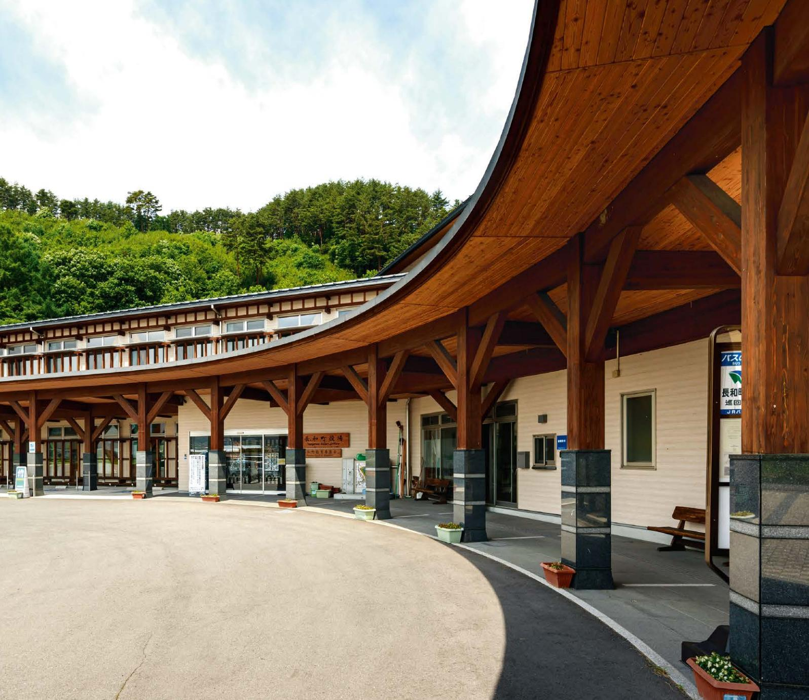
キャンपीは門型フレームで構成し、来庁者の動線と同じ桁行方向では、柱と梁の接合部を方杖で固めています。正面は交流・議会ゾーンです。
