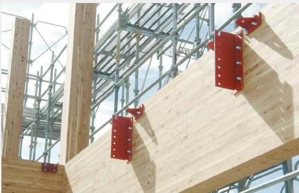
梁に取り付けた「TS金物」。両脇は水平平面に剛性を持たせるためのターンバックル付きプレース用の金物です。
